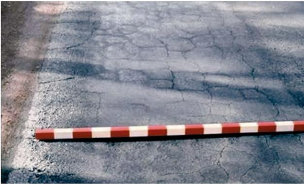
Figura 18. Fessurazione a fatica in una miscela di conglomerato bituminoso [45].
