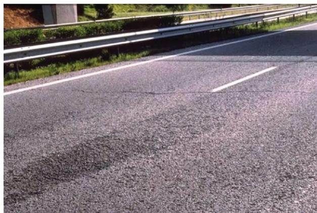
Figura 7. Spogliamento dell'aggregato causato dall'umidità [45].
