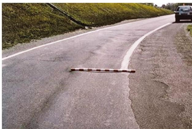
Figura 15. Ormaiamento di una pavimentazione flessibile [45].
